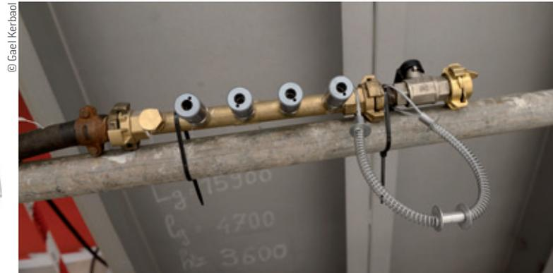
(Rampe pour alimentation en air comprimé)
